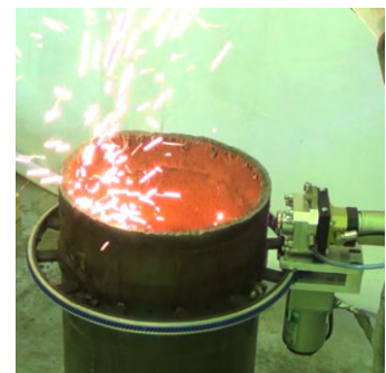
図 3 レーザー切断システムを使用した 250A 配管の切断
