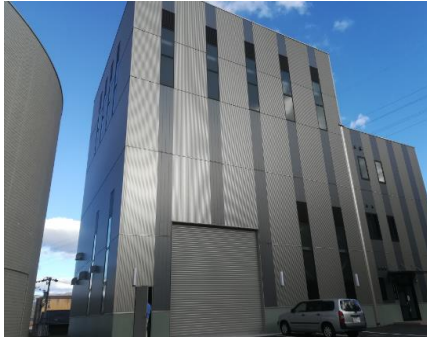
写真 1 ふくいスマートデコミッショニング 技術実証拠点、廃止措置モックアップ 試験フィールド
