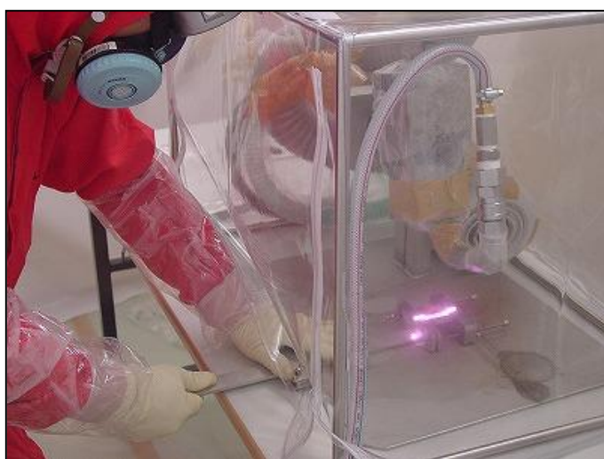
図2、以前行われた類似のレーザー除染作業。
