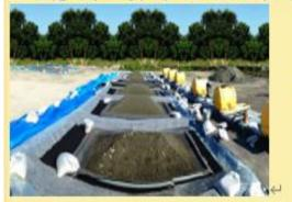
トンネル工事等で発生した土を仮 置きする際、盛土下部にシートを敷 設することで、浸出水に含まれる自 然由来重金属イオンを吸着する「吸 着シート」を開発しました。ゼ
