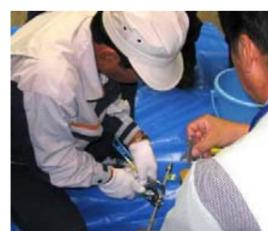
【配管締付継手】
