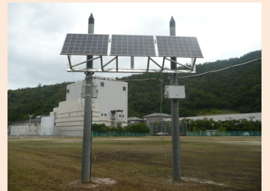
高浜町 関西電力原子力研修センター設置のパネル（傾斜角60度） ※関西電力提供
