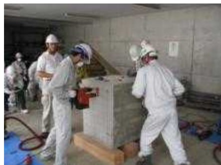
あと施工アンカー作業
