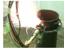
配管のレーザー遠隔切断
