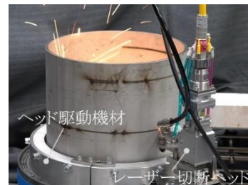
図2 300A配管の切断中の様子
