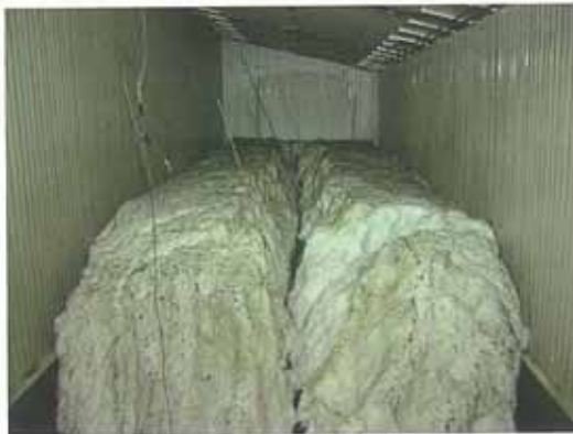
H19.7.25 冷房運転継続中 (外部排水量累計70ton、残雪率54%)
