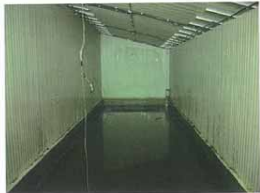
H19.8.22 冷房運転停止 (外部排水量累計139ton、残雪率5%)
