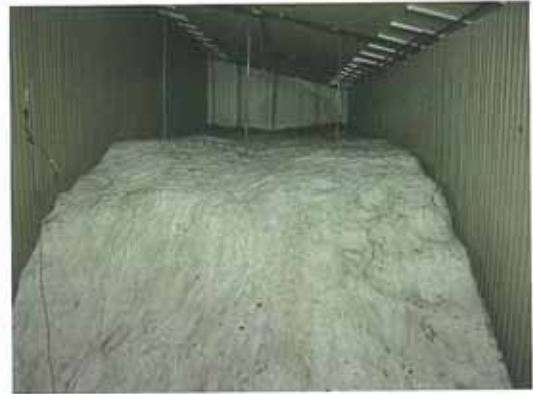
H19.7.2 冷房運転開始時 (外部排水量累計 26ton、残雪率 83%)
