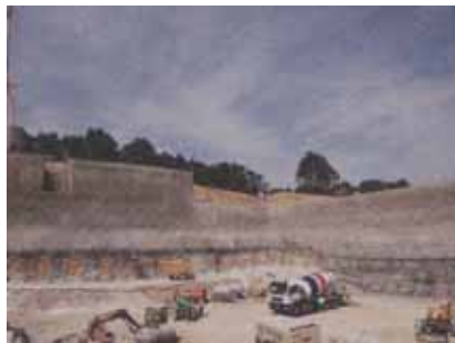
JHRの建設現場
