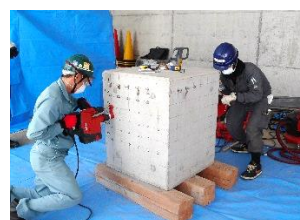
あと施工アンカー作業
