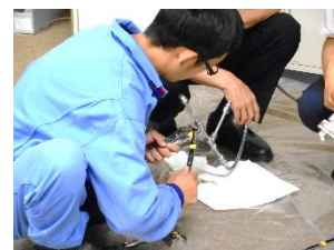
配管締付継手作業
